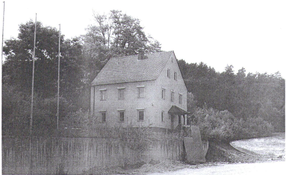
Die alte Ziegelei an der Bahnhofstraße soll der Verwaltungssitz des neuen ambulanten Kinderhospizdienstes in Marktheidenfeld werden. Die ambulante Einrichtung ist ein wichtiger Schritt zum eigentlichen Ziel des Fördervereins Sternenzelt, ein stationäres Kinderhospiz. Foto privat
